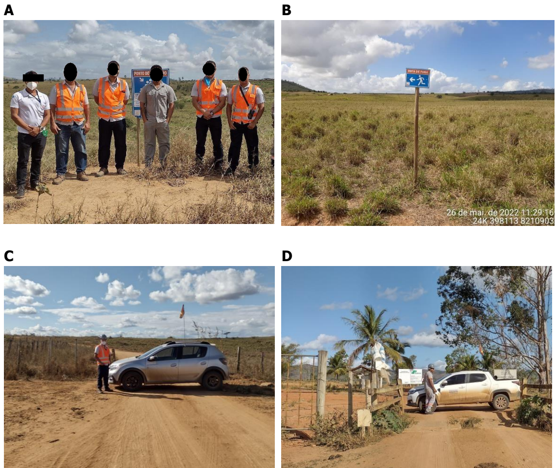
Figura 17.4 – Sinalizações ao longo da ZAS no formato demandado pela Instrução Técnica 01/2021 da CEDEC. A: Ponto de encontro para o caso de rompimentos da Barragem Califórnia. Os locais são sinalizados, espaçosos e estão em boas condições de conservação. B: Placa apontando direção do ponto de encontro. C e D: Bloqueio das vias de acesso para evitar acesso de transeuntes em área de risco
