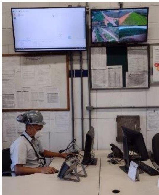
Figura 16.1 – Foto da sala de monitoramento e controle da barragem
